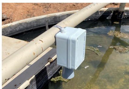
Sensor del nivel de agua ultrasónico montado en un tanque.
